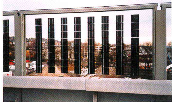
Bild 2. Das schallreflektierende Konzept des Züricher Projekts nutzt das Sonnenlicht beidseitig (Fotos: Kohlhauer, Gaggenau)
